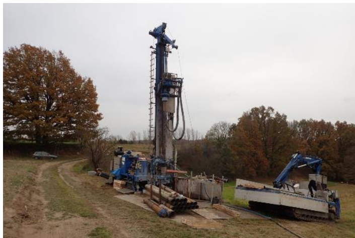
Abb.: BK-GWM 09/2021 - Bohrarbeiten
