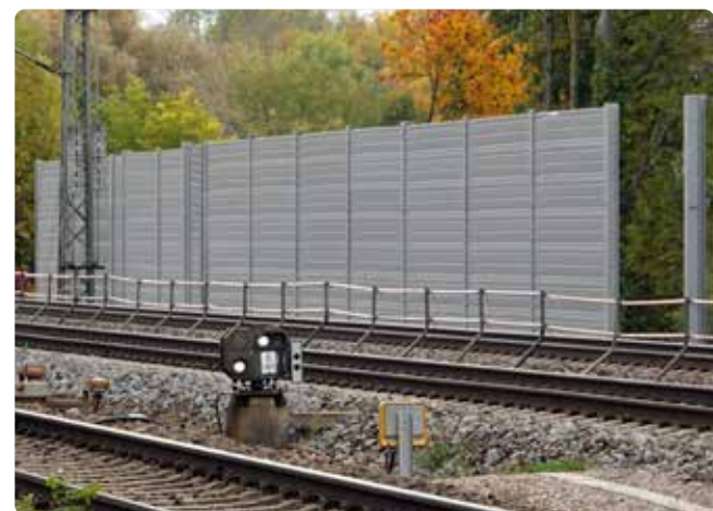
Bau von Lärmschutzwänden
