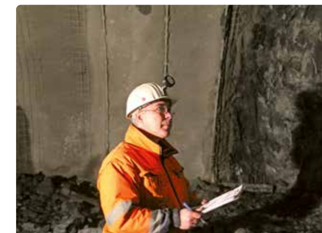
Bergmännischer Tunnelbau: Geologe begutachtet die Gesteinsformationen zwischen den Sprengungen
