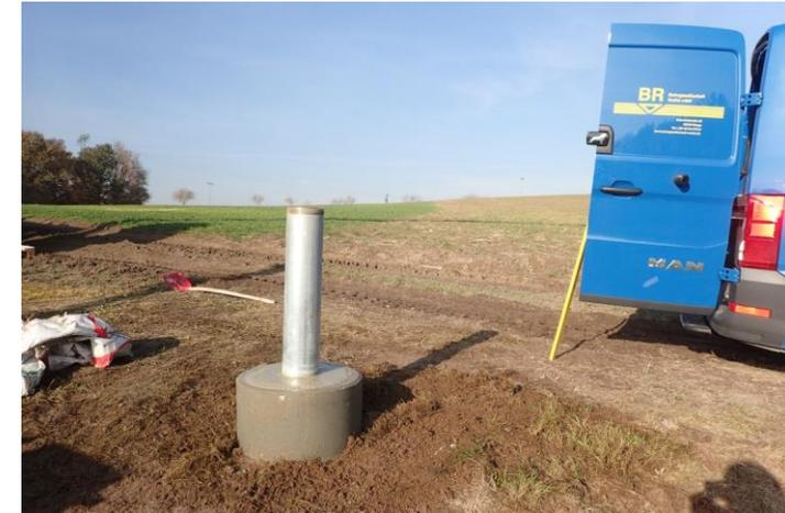
Abb.: fertig ausgebaute Grundwassermessstelle
