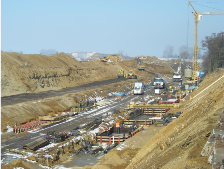
Das Kreuzungsbauwerk Kottewitz im Bau 2010 (Quelle: DB Netz AG)
