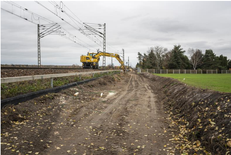
Bauarbeiten im Abschnitt Zeithain–Leckwitz 2020 (Quelle: DB Netz AG/Jörn Daberkow)
